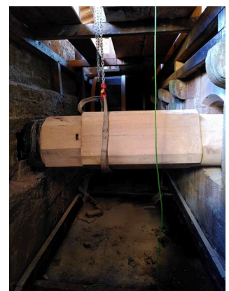
Die neue Welle besteht aus fünf Jahre abgelagertem Eichenholz. © SG, Foto: Christoph Haarmann
