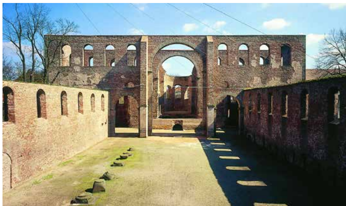
Blick auf das zerstörte Langhaus
