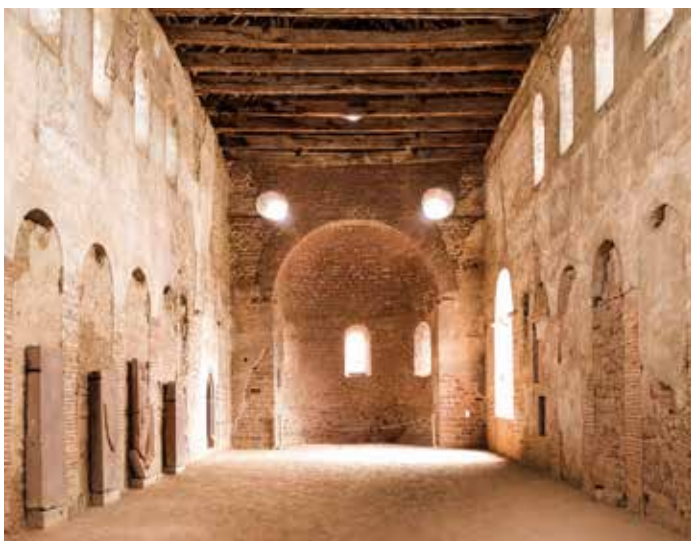
Innenansicht des Mittelschiffes
